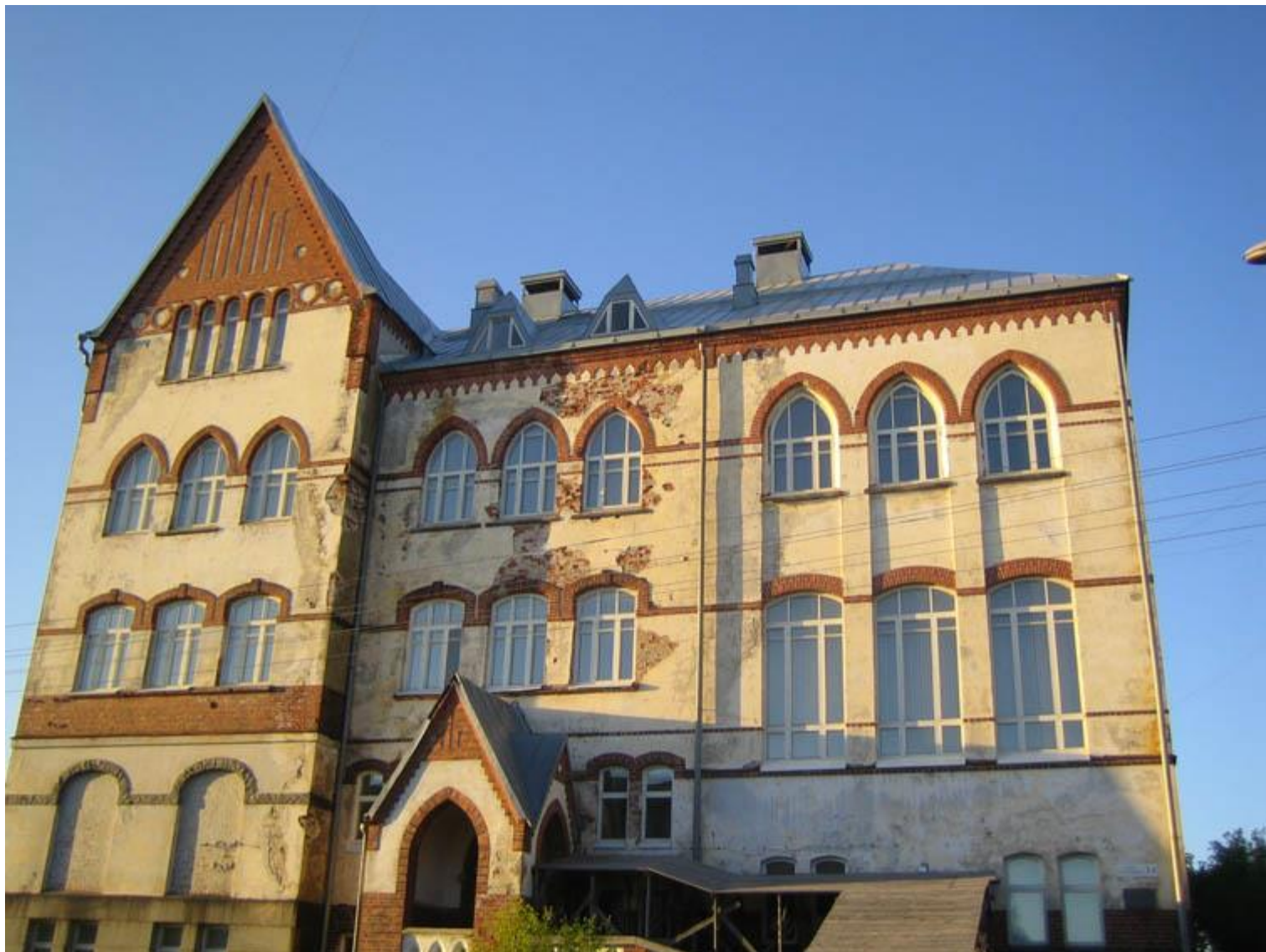
Vuonna 1857 perustettu Sortavalan tyttökoulu toimi tässä rakennuksessa 1912 – 1939. Nyt rakennus oli korjattavana
