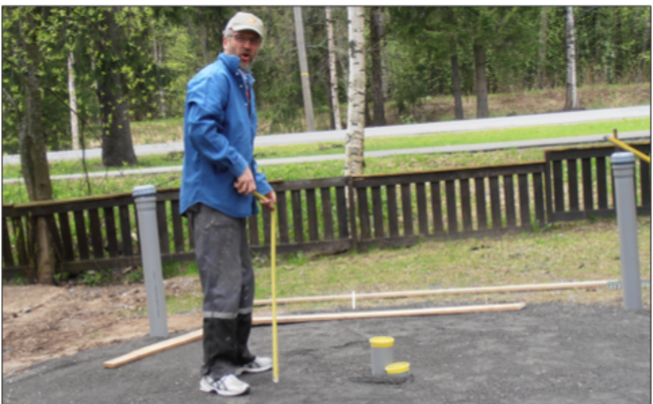
Koivulan grillikodan rakentaminen tehtiin velli Hannu Tuhkalan toimiessa projektipäällikkönä.
